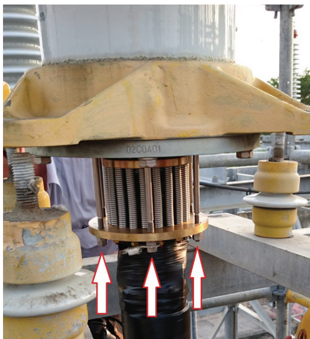
圖 16 壓縮裝置需逐點確認鎖固
