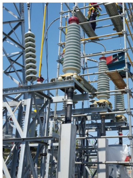
圖 1 岡山~橋頭紅線#1 連接站
