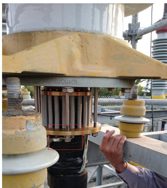
圖 11 遮蔽銅線壓接端子鬆脫處
