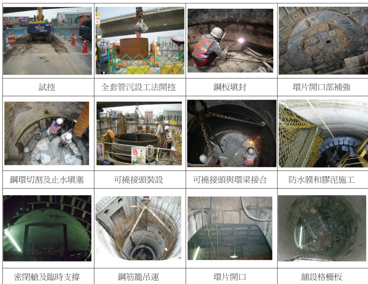
圖 22 高港鳳林路段案分歧井施工
