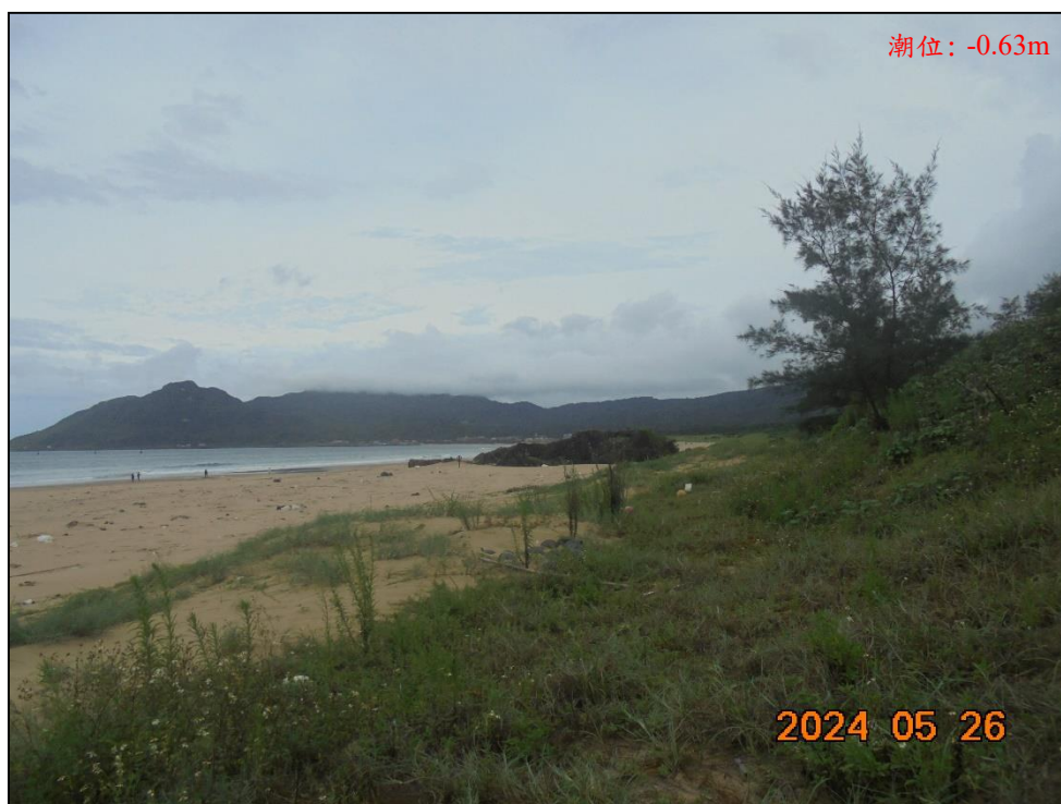
圖 4-14(B) 監測區南側大岩礁（黑石仔）旁防風籬地形（2024/05/26）
