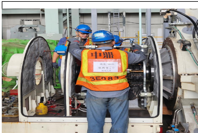
主發電設備工程 Unit 2 STG 設備安裝
