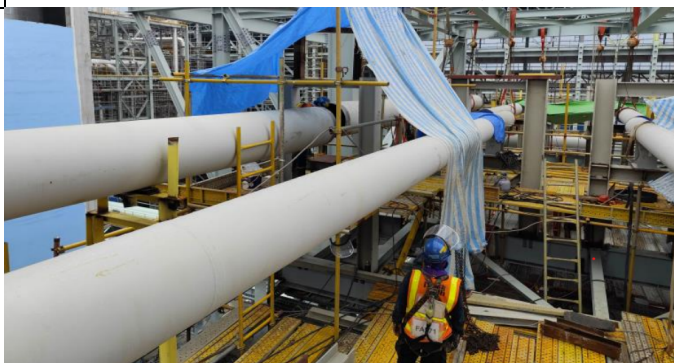
主發電設備工程 Unit 3 MPR 配管
