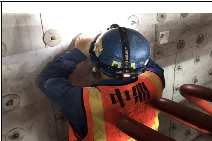
主發電設備工程 Unit 2 HRSG 2-2 設備保溫
