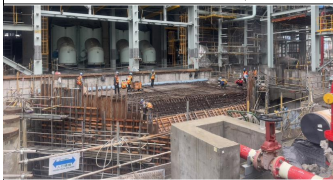
主發電設備工程 Unit 3 進水喇叭口 結構體
