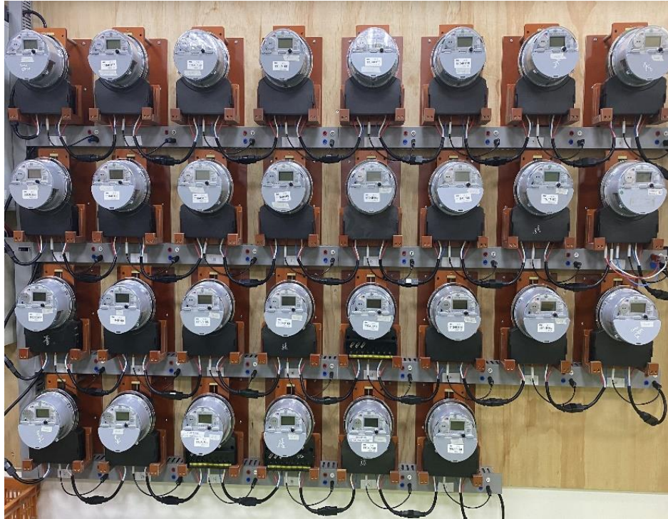
三相表盤設備安裝示意圖
