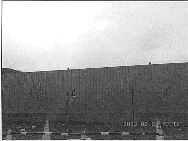
營建噪音：電氣室旁(112.02.08)
