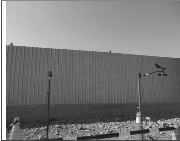
營建噪音：電氣室旁(111.12.27)
