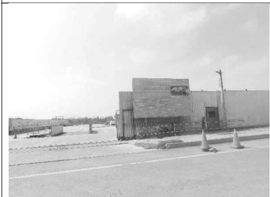
29. 彰工升壓站工程告示牌
