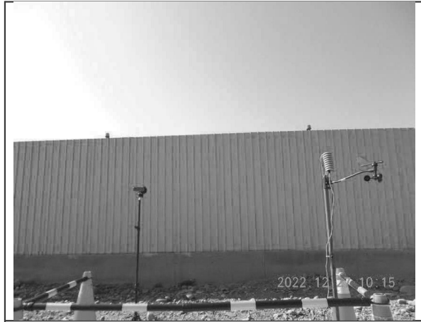
低頻噪音：電氣室旁(111.12.27)
