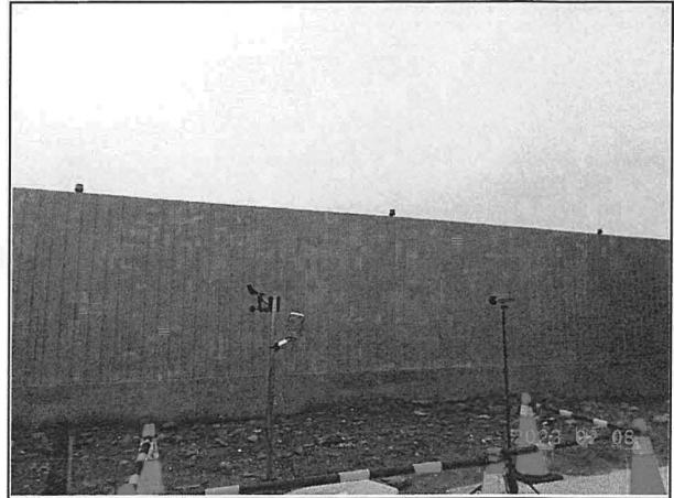
低頻噪音：電氣室旁(112.02.08)
