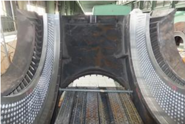
圖 13 安裝擋板於倒數第二級(L-1)靜葉片位置
