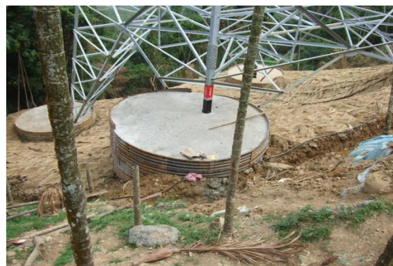
圖 9 土壤基礎完工
