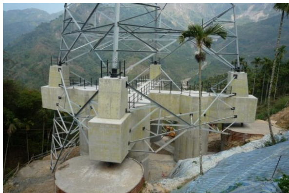
圖 10 永久基礎完工
