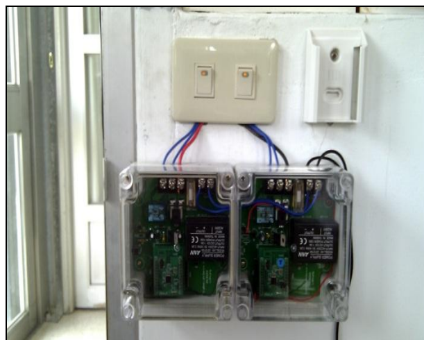
圖 8 ZBee 照明節點安裝完成圖
