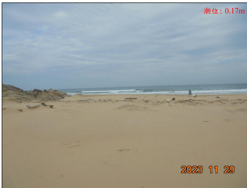
圖 4-12A 監測區南側大岩礁（黑石仔）後方碇堡（2023/11/29）
