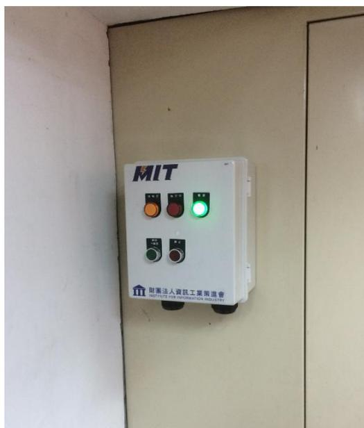
圖 7 安裝於中控機房的 VEN 控制器
