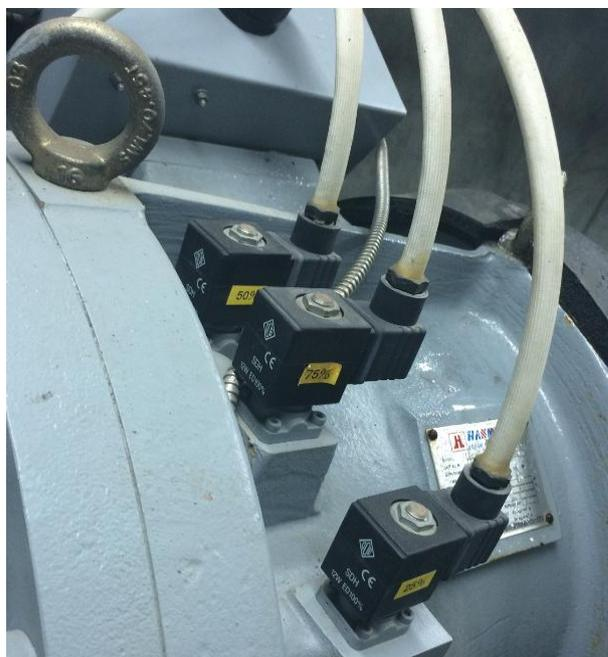
圖 9 有段式的負載控制點電磁閥
