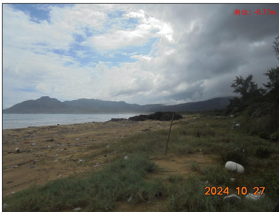
圖 4-14(B) 監測區南側大岩礁（黑石仔）旁防風籬地形（2024/10/27）
