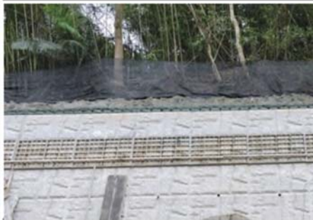
三灣大河底野溪整治三期工程-施工邊界設置黑紗網降低對動物干擾
