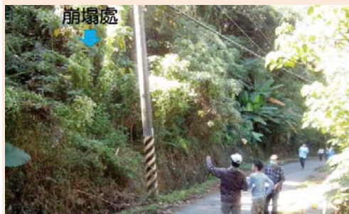
南化水庫道路水土保持工程 坡面穩定植生恢復，工程取消(退場機制)
