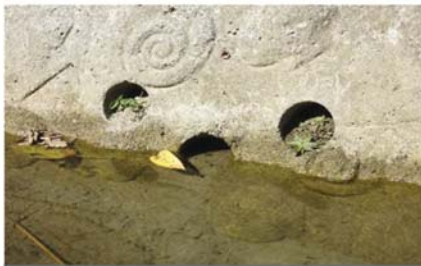
頭汴坑溪中埔十號橋上游整治工程-護岸設置生物棲避設施
