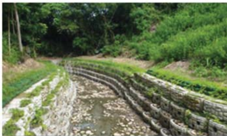
大砲崙野溪整治工程-預鑄護岸營造植生復育基盤
