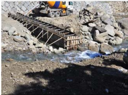
阿里不動溪二期整治工程-將溪水導離工區避免水質汙染
