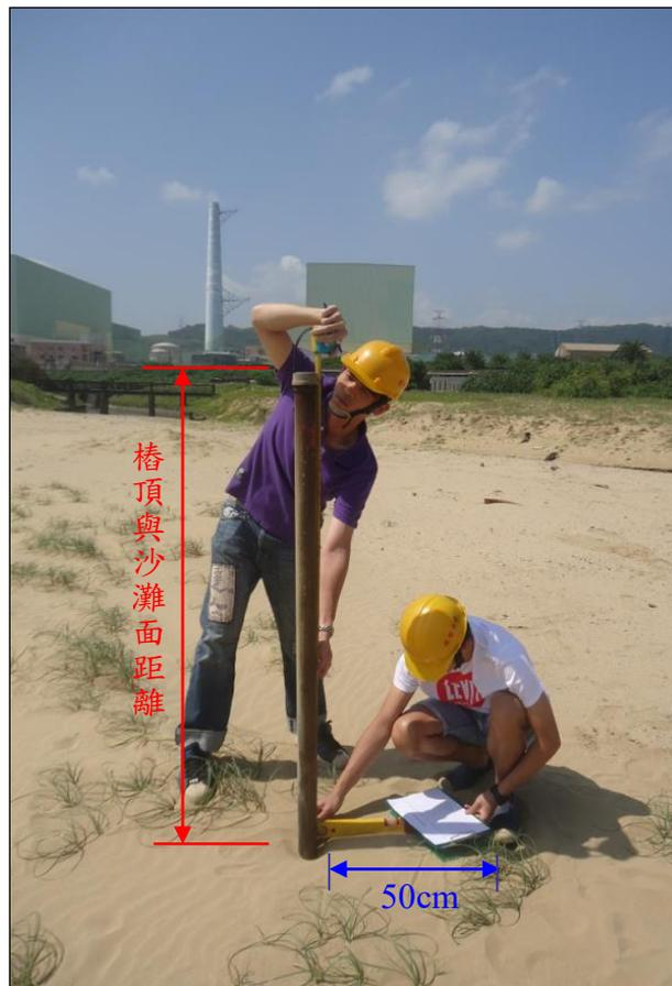
圖 3-15 輔助樁沙灘監測作業情形圖
