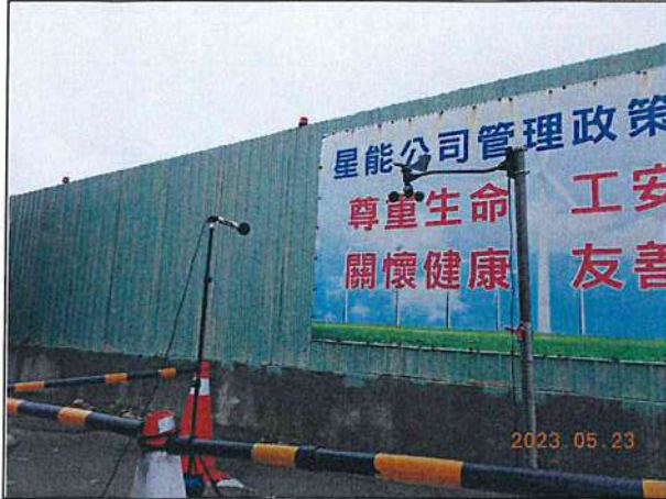
營建噪音：電氣室旁(112.05.23)
