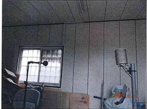
低頻噪音：電氣室旁(112.05.23)
