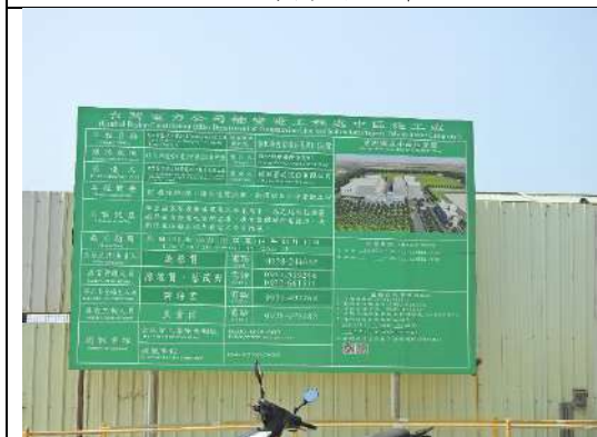
31. 彰工升壓站工程告示牌
