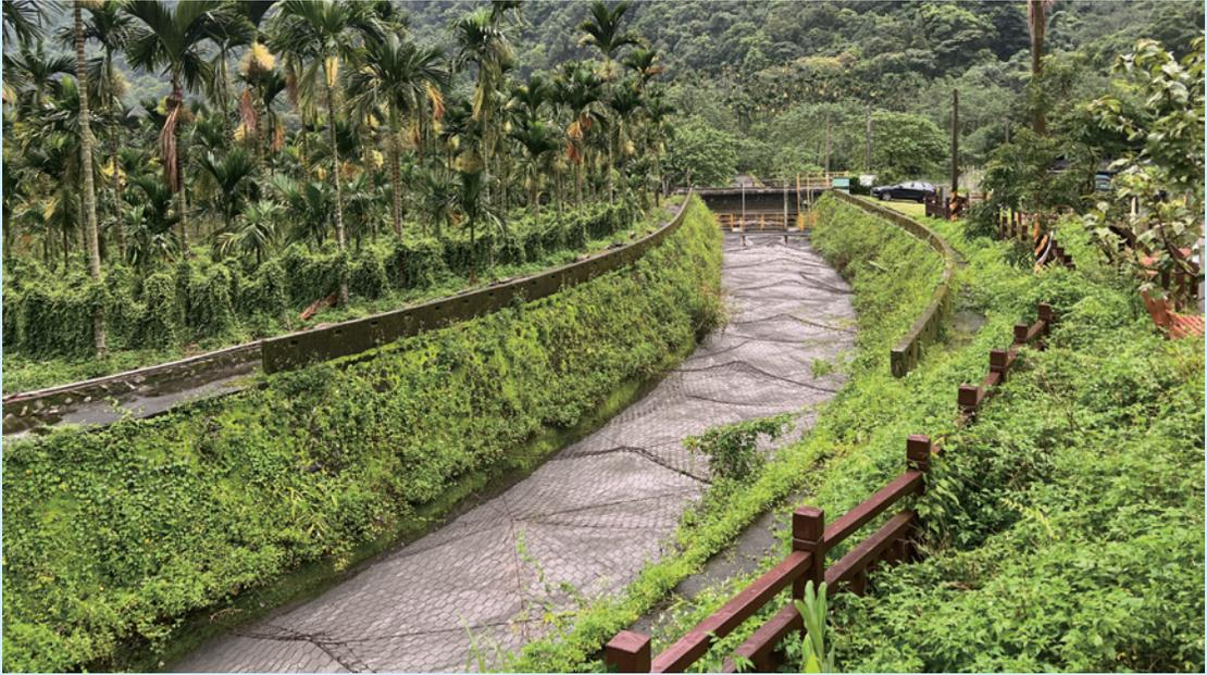
水庫經萬大發電廠、松林分廠發電後的溪水，透過武界壩攔截，引進引水隧道送至日月潭，民國 95 年因應武界引水隧道使用多年結構老化，輸水能力下降，台灣電力公司完成新武界引水隧道，而兩座隧道行經東光社區山谷時，因地形上的限制，舊武界隧道在此擁有唯一一段可見光明約 700 公尺長的明渠，而得名為「向天圳」，於東光溪上方，舊武界隧道設有一座長 76.9 公尺的過水陸橋，橋中段還有一條鋼管引接隧道流水供應東光村，至於新武界隧道因地勢較低，因此以暗渠方式通過東光溪。
