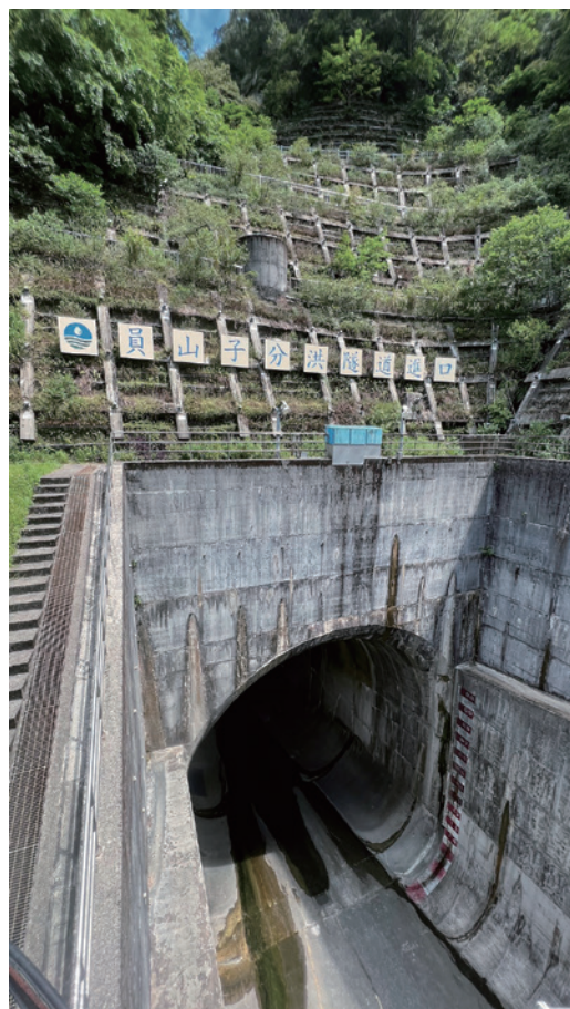
通往金字塔古道的瑞猴公路上，會看到北臺灣極其重要的水利設施員山子分洪道的隧道進口。
