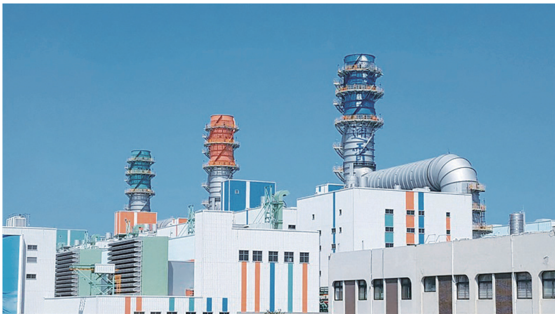
電廠直供園區用電，是電網強韌重點項目之一。
