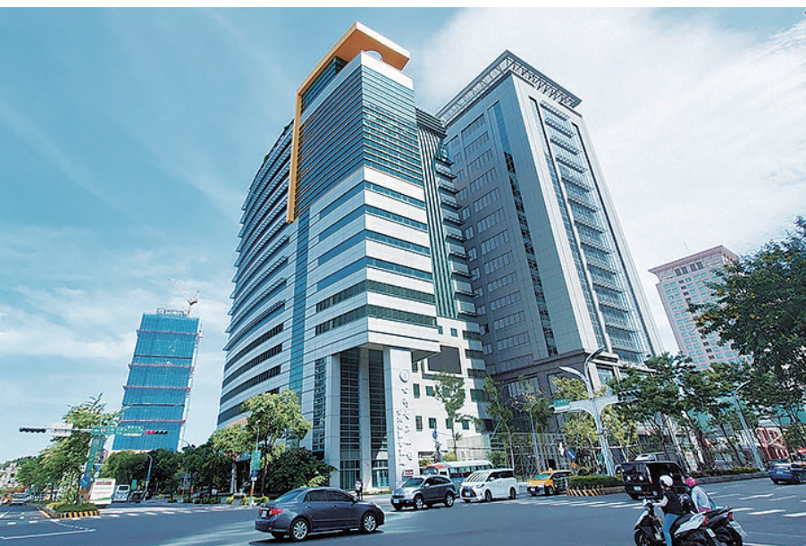
位於新北市新板特區的新民變電所，是一棟多目標使用大樓。
