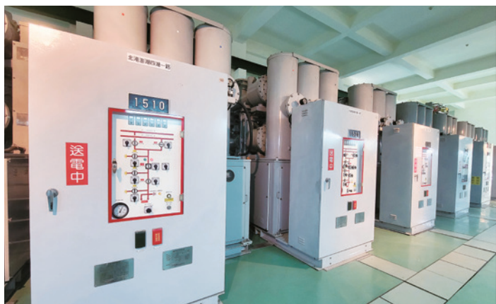
臺灣及澎湖兩端均設有海纜相關機電附屬設備，可偵測海纜外傷、溫度及故障定位。
