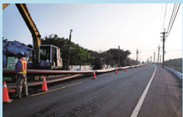
臺澎海纜上岸後的最後一哩陸管鋪設，在歷經多次與民衆的溝通後，採用推管方式施作，降低道路的開挖，避免造成鄰損。
