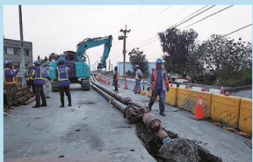
臺澎海纜上岸後的最後一哩陸管鋪設，在歷經多次與民衆的溝通後，採用推管方式施作，降低道路的開挖，避免造成鄰損。
