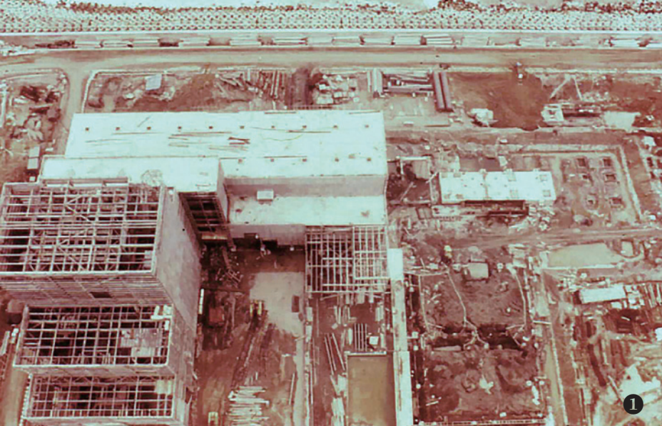
❶ 民國 63 年協和發電廠進行鍋爐、汽機房建築 (協和發電廠提供)。
