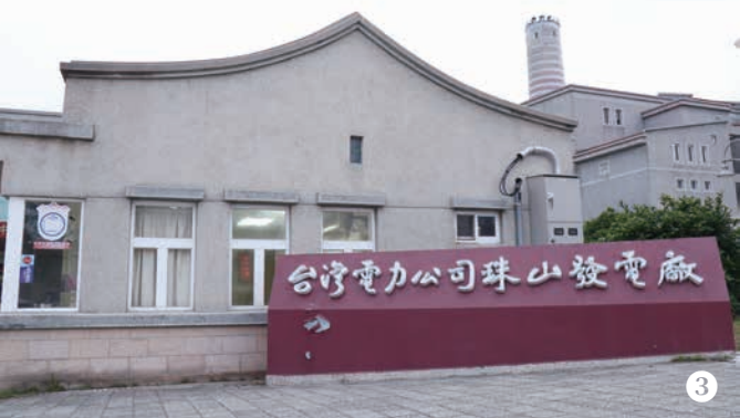
❶ 台電東莒發電廠 (黃芷庭提供)。❷ 台電珠山發電廠內的發電機組。❸ 台電珠山發電廠廠房融入閩式建築風格。
