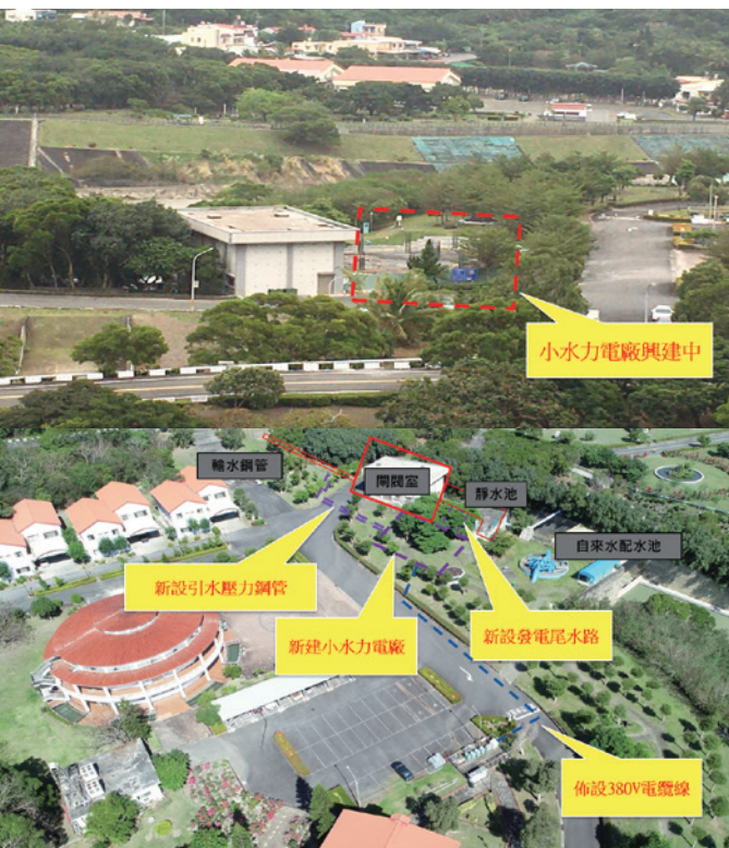
牡丹小水力發電廠配置圖與施工近況，將臺灣水力發電版圖一舉延伸到國境之南的恆春半島。（牡丹水庫管理中心提供）
