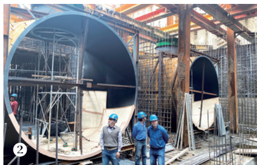
① ② 正在進行地下基礎與水輪機組件安裝的集集攔河堰南岸第二跌水工發電廠。（南寧工程公司提供）
