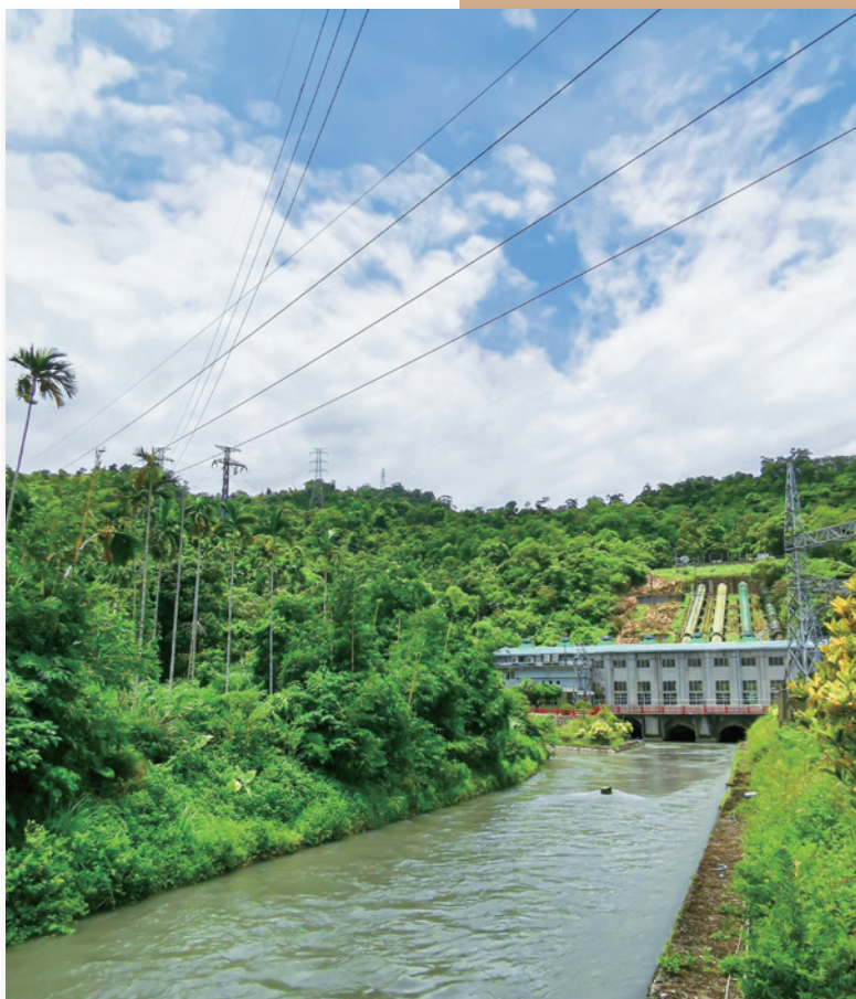
台電蘭陽發電廠 楊雯茹攝
