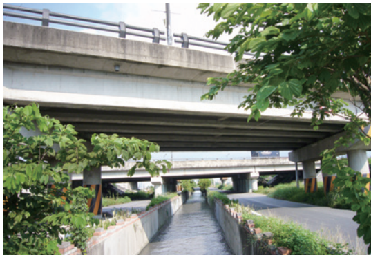
▲ 高速公路跨圳而過。
