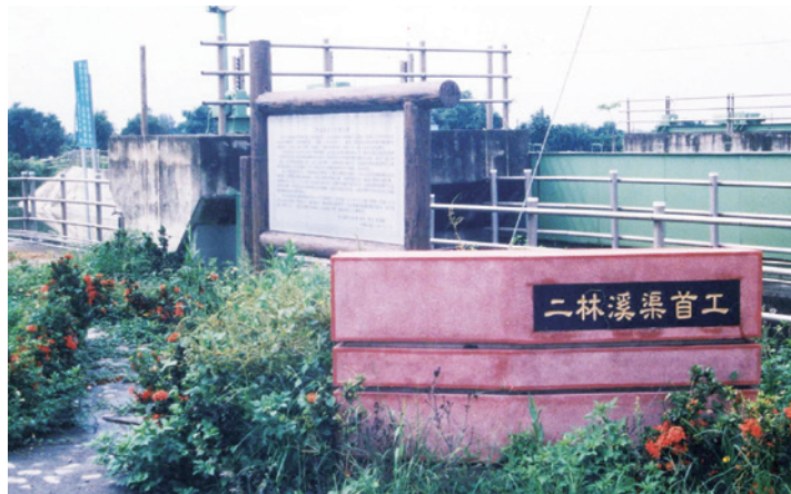
▲ 二林溪渠首工。
