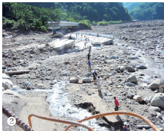
① 莫拉克災後搶修期間，山區道路柔腸寸斷，只能依靠最值得信賴的一雙腳走出前進災區的道路。
