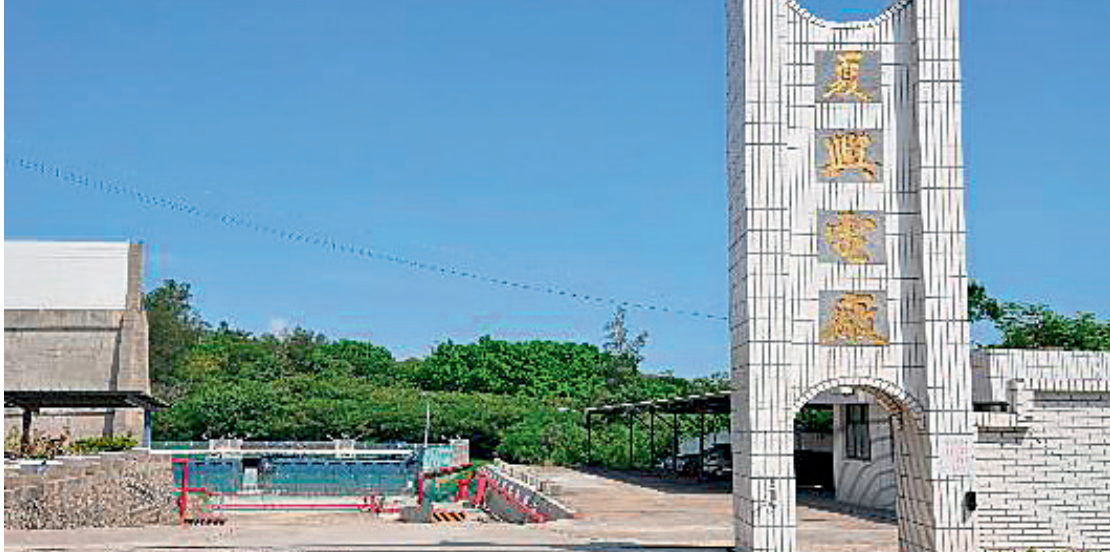
▲ 台電公司夏興發電廠。
