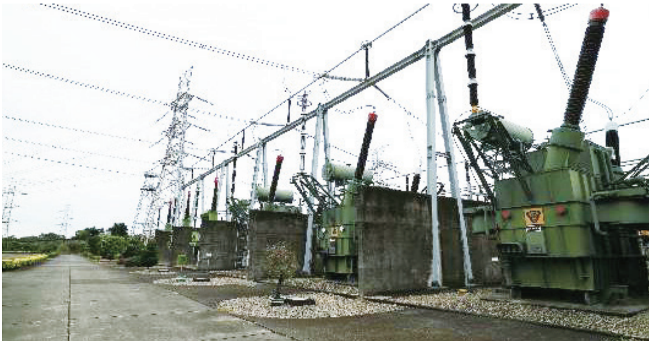
▲ 龍崎超高壓變電所 345 千伏自耦變壓器一景，已為臺灣電力貢獻近 40 年的機組仍保持良好機能持續運轉中。
