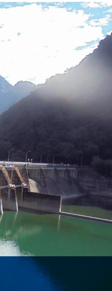
▲ 從馬鞍壩的觀景平台，可觀看馬鞍壩、魚道、排砂道及大甲溪。
