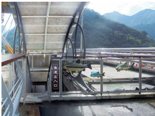
▲ 馬鞍壩魚道的參觀者出入口。
