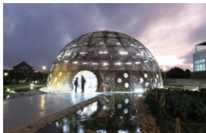
▲「竹穹惜水」夜景夢幻唯美，實際功用為污水處理中心。
