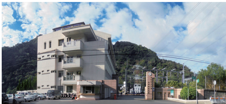
▲ 大甲溪發電廠的大門口。
