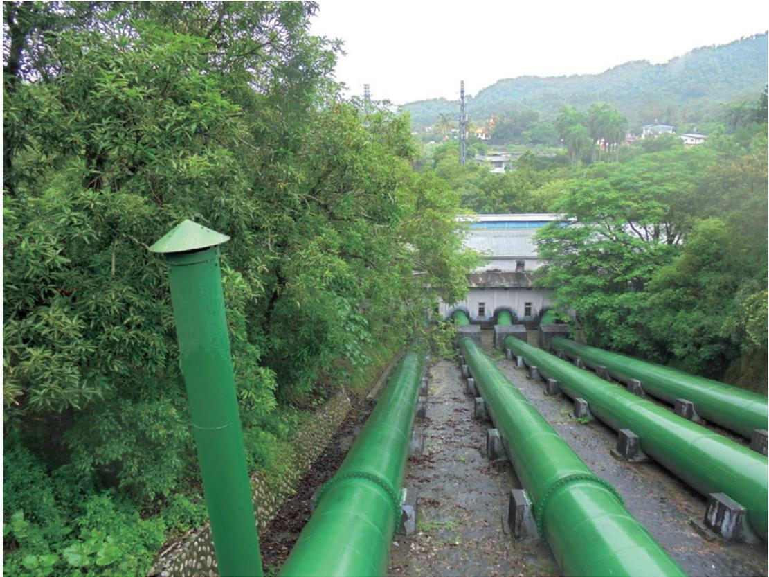
▲ 竹門發電廠舊機組的壓力鋼管。
