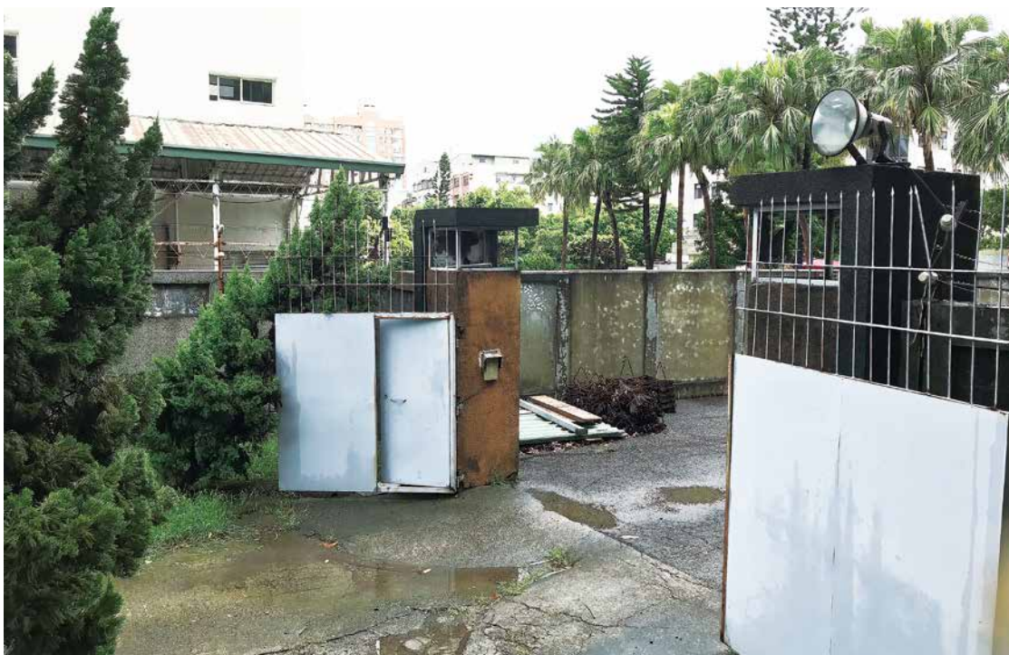
▲ 三民一次配電變電所。
