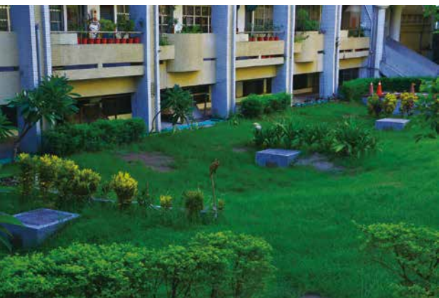
▲ 加昌國小打造校園中庭生態島的概念，白色的方形體就是雨水排泄池，能達到涵養水源的作用。
