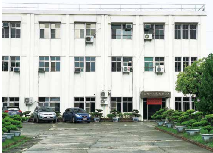
▲ 電力修護處南部分處行政大樓外觀，高雄發電廠裁撤後一分为二，一半成為三民一次配電變電所，另一半就成了照片中的電力修護處南部分處。
