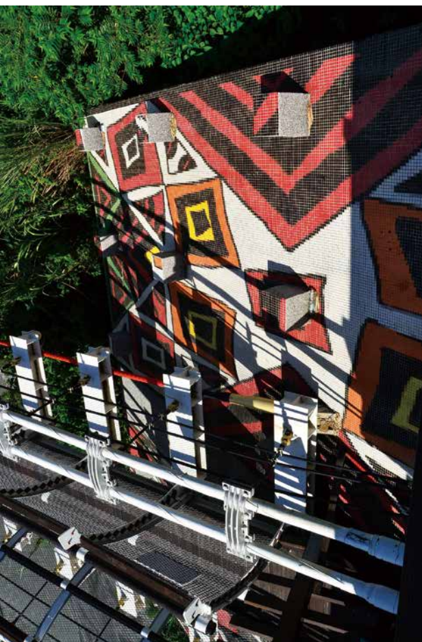
▲ 吊橋兩端擋土牆上也是色彩斑斕的部落圖騰。
