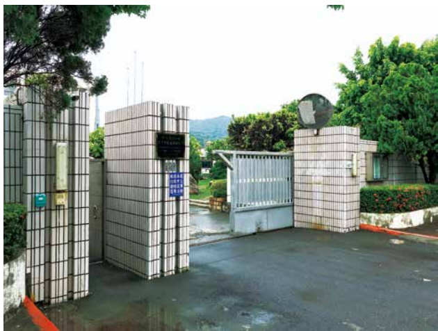
▲ 電力修護處南部分處大門，為台灣電力公司於南部地區重要的機電設備修護中心。
