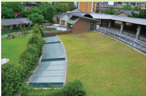
▲ 專科教室的上方為覆土式屋頂，既達到綠美化，又能有效降低室內溫度。
