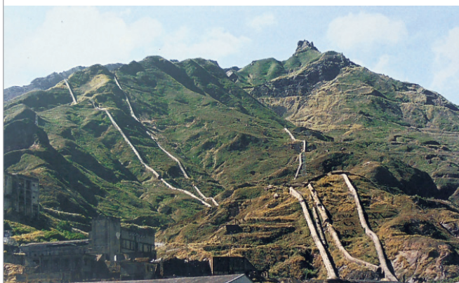
▲ 水湳洞廢棄煉金廠房（十三層）遺址旁早年建造的三條翻山而過的龐大排煙管綿延數公里，號稱世界上最長尚可看到排煙管（鄭春山先生提供）。
