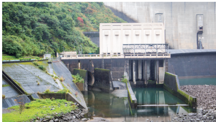
▲ 翡翠發電廠尾水出口與照片左方的排洪隧道出口。
