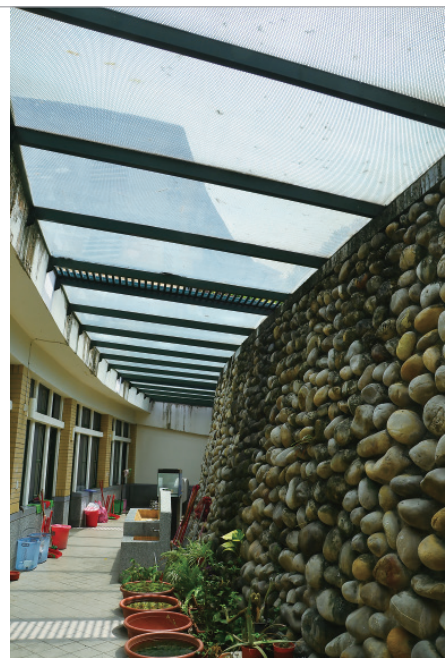
▲ 專科教室外的擋土牆是開挖地基時取得大量的卵石堆砌而成，一方面節省了建材購置，另一方面岩石壁面也有美觀和減少碳足跡之效。
