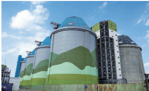
▲ 林口發電廠的室內煤倉。
