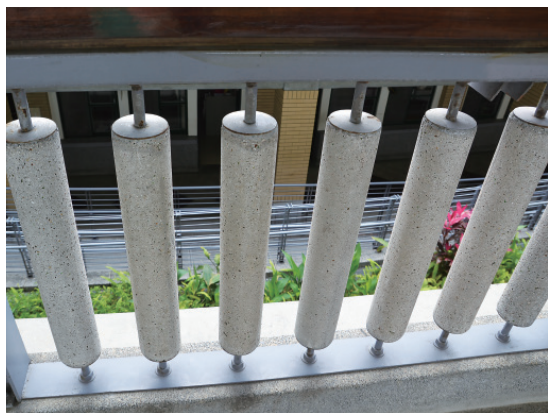
▲ 迴廊女兒牆的圓柱護欄是零碎水泥塊壓碎後塑造造成的，屬於綠色再生建材。
