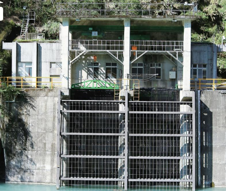
▲ 義興發電廠進水口，為直立塔式結構。
