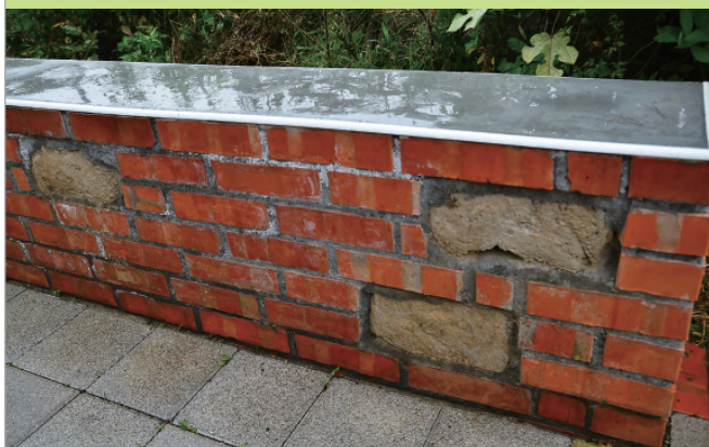
▲ 椅凳的紅磚塊間還穿夾著幾塊從老屋斷牆上取下的土塊，頗費心思的想法讓土角厝的土塊有了新生命。
