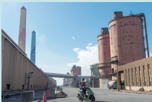
▲ 台中電廠排煙脫硫設備。
