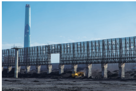
▲ 防風網可降低風速，減少露天煤場的揚塵。
