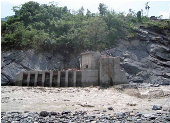
▲ 莫拉克風災後第十天，由巡檢的高屏電廠同仁拍下進水口攔汙柵損壞情形。
