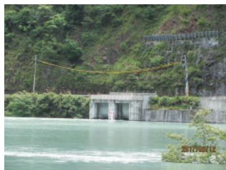
▲ 滿載發電的尾水出口。
