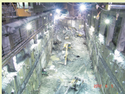
▲ 地下廠房復建。
