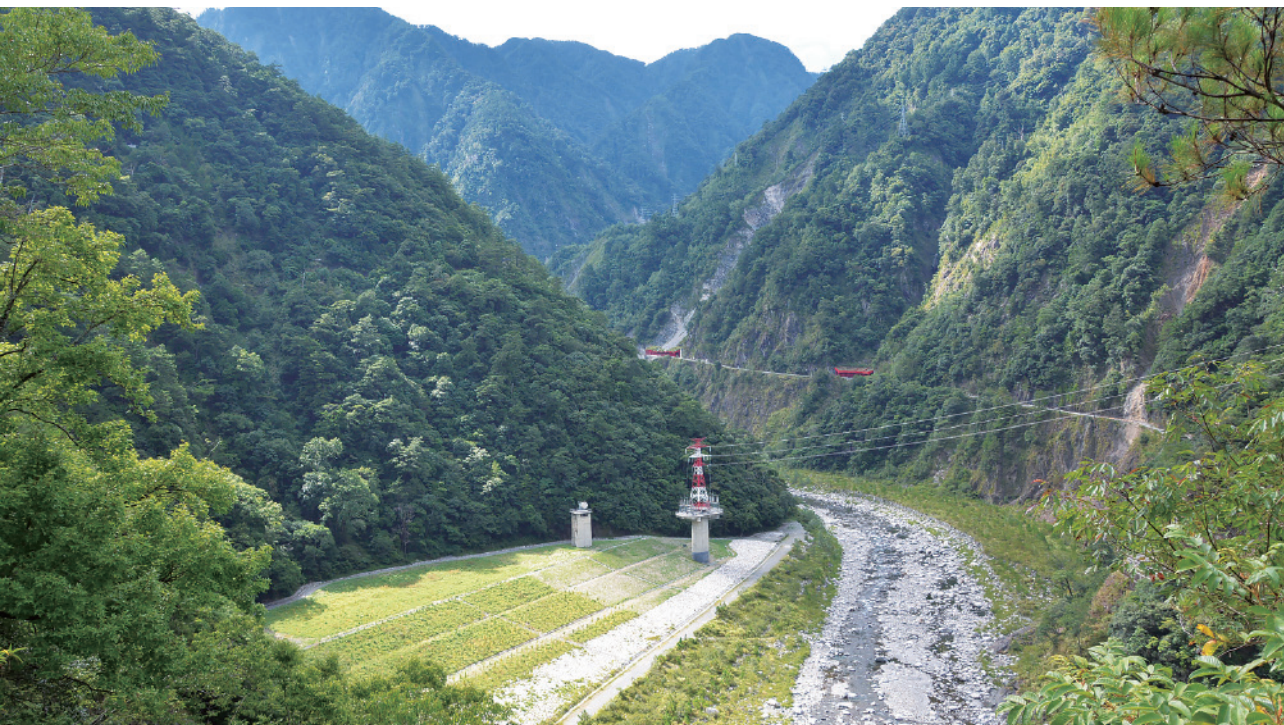
▲ 既有開關場區完工照片。
