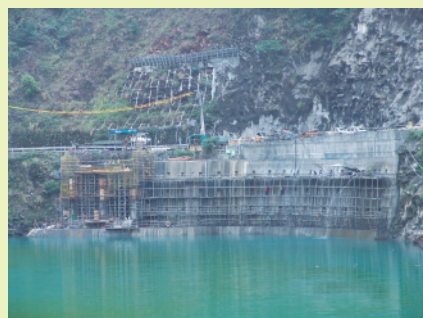
▲ 尾水出口結構物興建。
