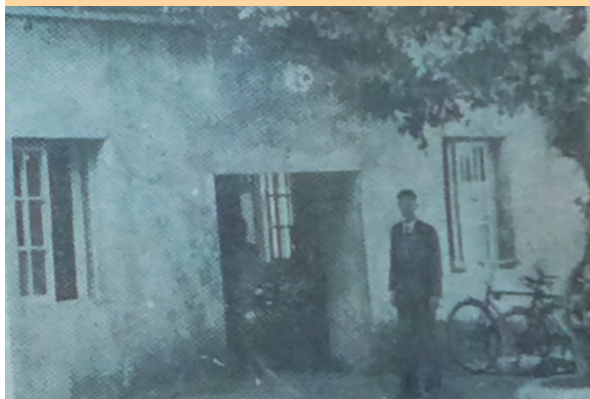
▲ 太平發電廠廠房一景，花東縱谷連續地震後發電量大增，總管理處隨即派員視察。(台電勵進月刊)
