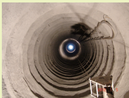
▲ 240 公尺通風直井開挖完成。
