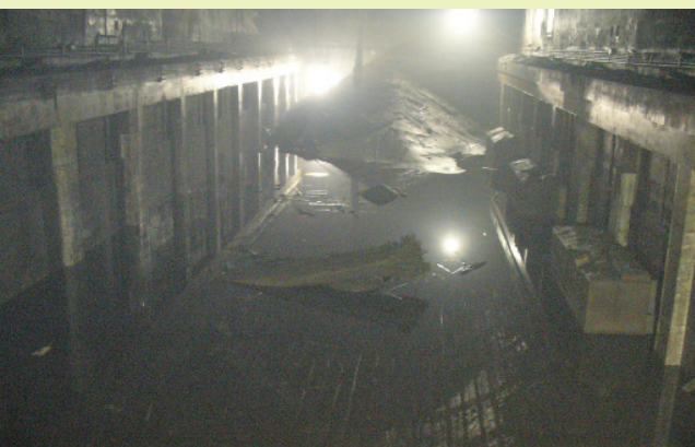
▲ 93 年 72 水災洪水及土石沖入地下廠房 (大甲溪發電廠提供)。
