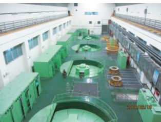
▲ 浴火重生後的地下廠房。
