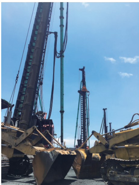
▲ 砂樁機加密夯實煤灰
