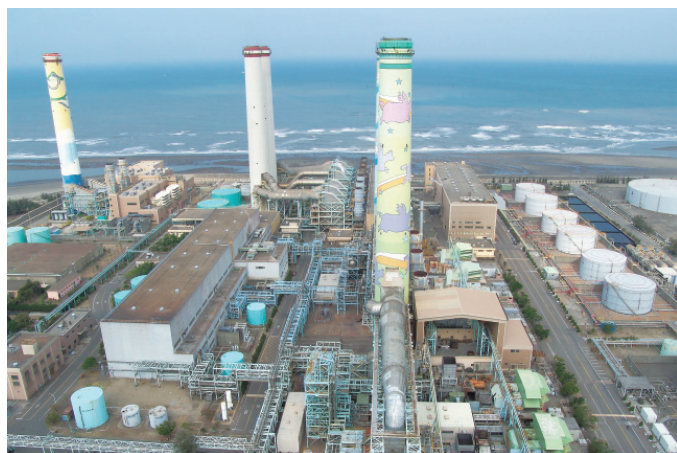
▲ 通霄發電廠運轉中的複循環機組。
