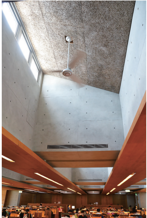
▲ 4樓溫書室天花的設計結合了燈具、吊扇、天窗和空調出風口，天窗可透過電動開啓，除採光外更具有通風的功能。
