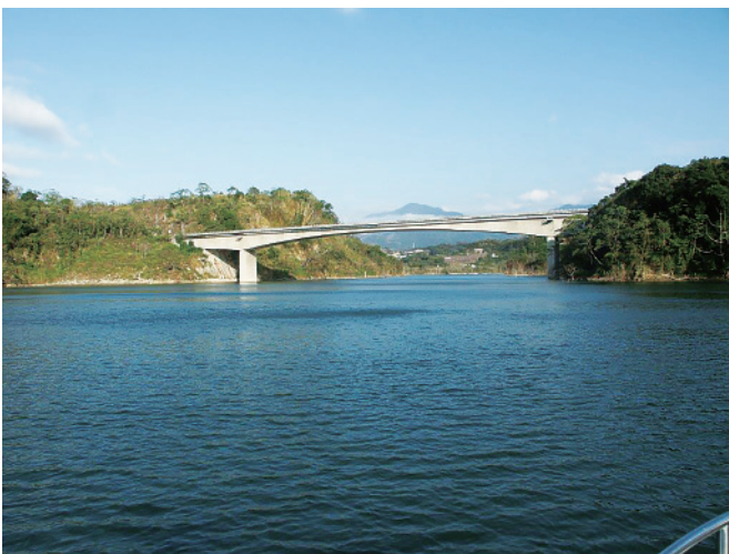
▲ 自鯉魚潭水庫觀望臺三線的景山橋。
