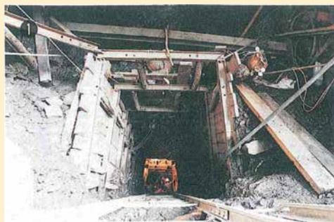
▲ 龍溪發電廠壓力鋼管斜坑開挖作業。
