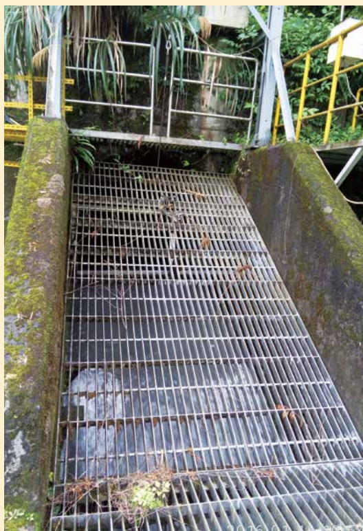
▲ 奇萊引水隧道的出口，匯集了木瓜溪上游五條支流清澈的溪水注入到龍溪調整池中。
