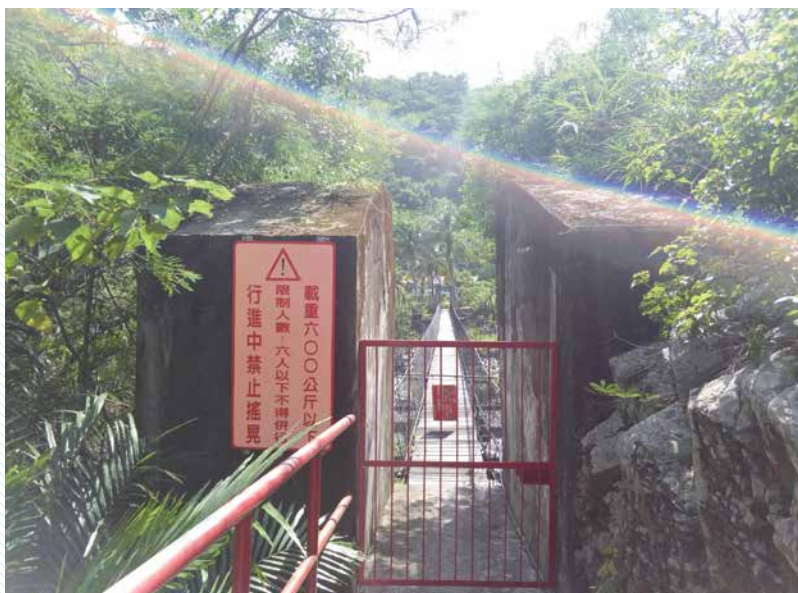
▲ 僅能 6 人以下行人電廠唯一聯外的小吊橋。
