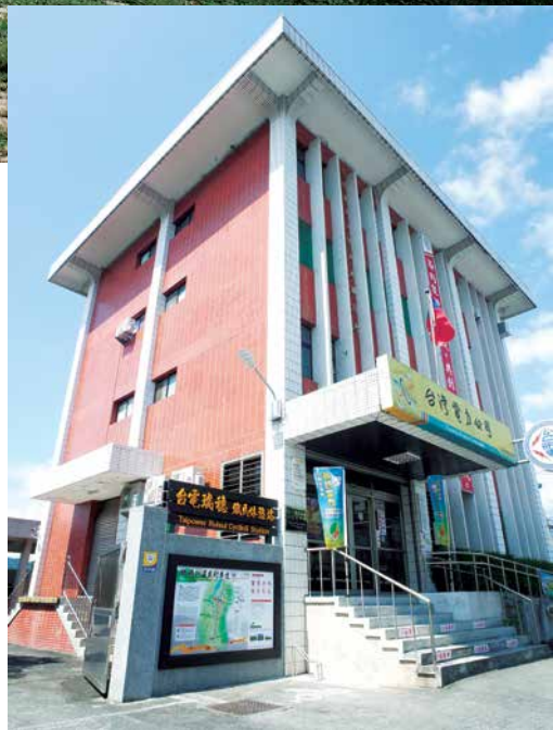
▲ 台電公司瑞穗鐵馬休憩站。
