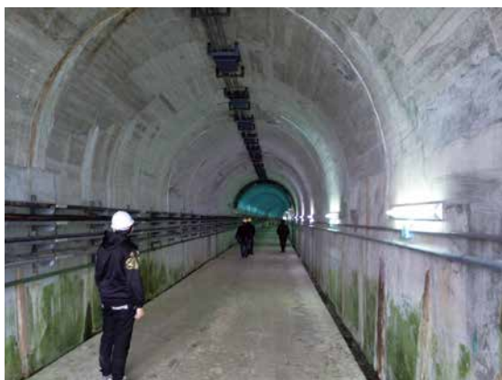
▲ 筆直的地下廠房通達隧道，隔絕著裡外不同的環境。
