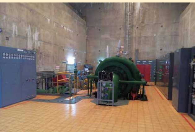
▲ 地下廠房裡運轉中的橫軸法蘭西斯式水輪發電機。 ▲ 各項與機組相關的控制盤。
