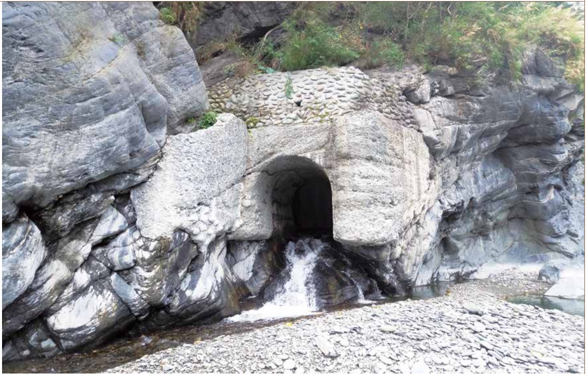
▲ 發電廠舊尾水隧道出口，可看出已用混凝土封堵的痕跡。
