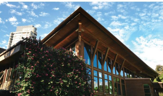
▲ 窗屋的設計，讓室內可以採集到大量的自然光，植生牆則可以阻隔日曬及達到降低室溫的作用。
