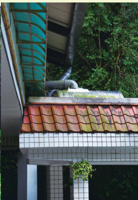
▲ 校園建築的各個屋頂角落都可見這種粗大的集水管，以收集雨水。
