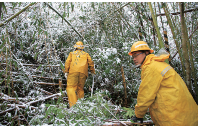
▲ 桃園復興區雪害線路搶修 (台電公司配電處提供)。
