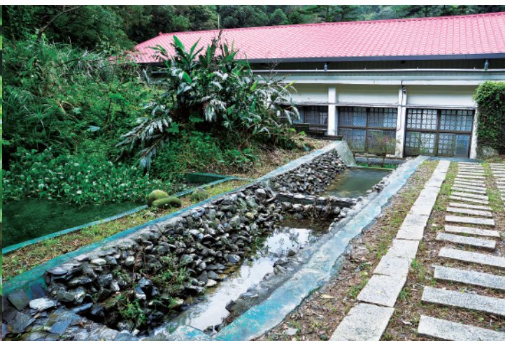
▲ 瑞柑國小第一生態村在校舍後方的山坡，排水溝渠以生態工法做截流，達到蓄水的目的，並兼顧生態。
