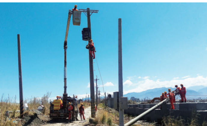
▲ 尼伯特災後搶修實況 (台電公司配電處提供)。
