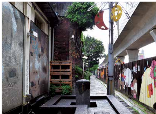
▲ 這些鐵道舊倉庫隨著臺中鐵路高架橋一路向遠處延伸。
