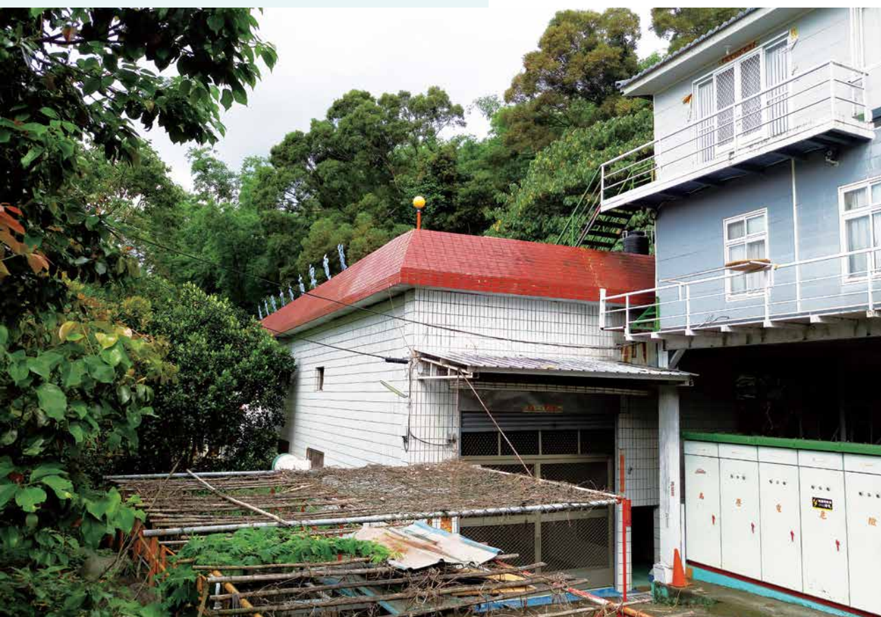
▲ 卑南上圳發電廠廠房外觀
