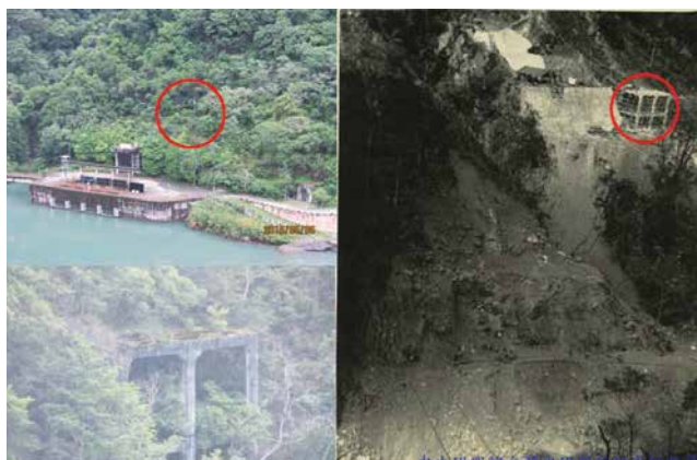
▲ 明治堰堤（現天輪壩）今昔對照
