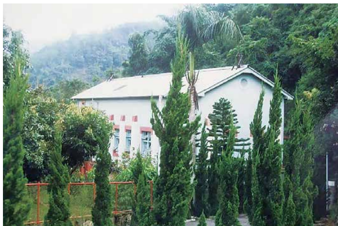
▲ 北山發電廠改建前廠房
