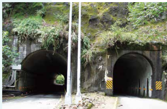
▲ 位於中橫 35.7k 谷關舊（右）隧道（日治末期），新（左）隧道（民國 50 年代），二者皆由台電完成。
