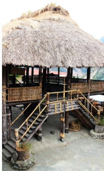
▲ 杆欄式建築的 Kuba，取材大自然，不用一根釘子。
