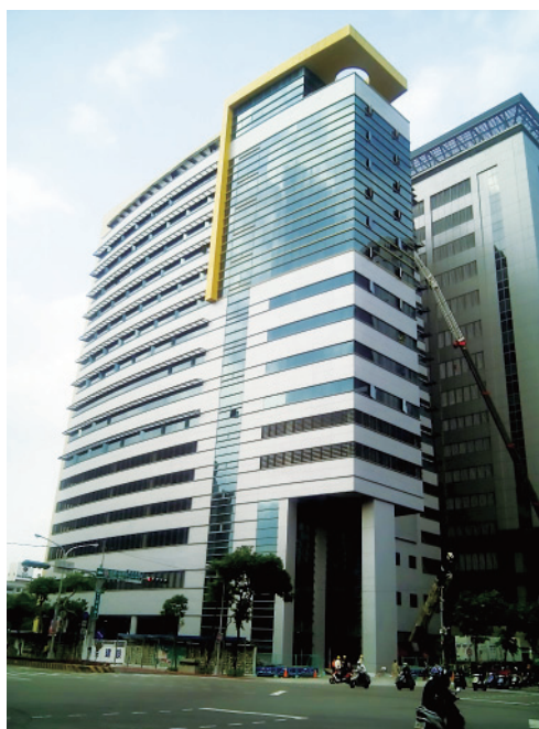
▲ 新建的板橋新民屋內式超高壓變電所。
