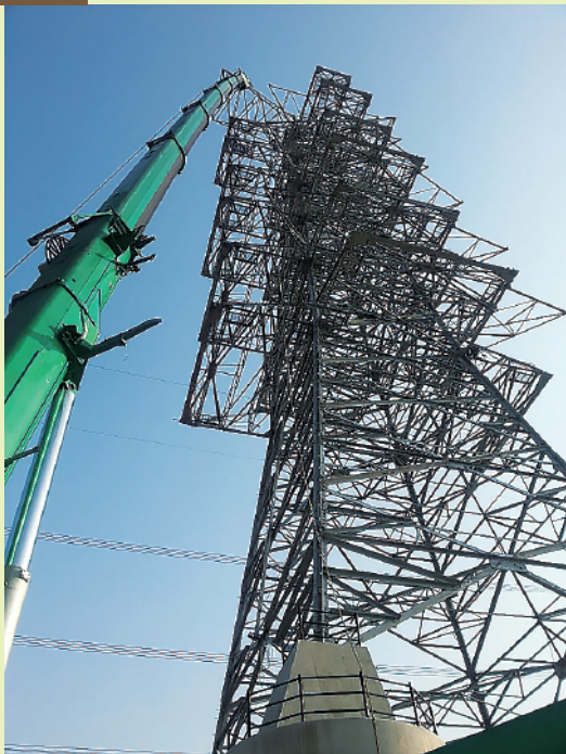
▲ 第七輸變電計劃中，此鐵塔為全台最重的高壓鐵塔。
