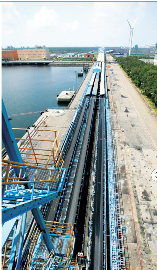
③ 由台中港專用卸煤碼頭直通台中發電廠的運煤輸送帶
