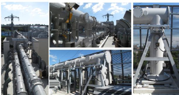
圖 30 變壓器一次側用 GIB 配置實況
