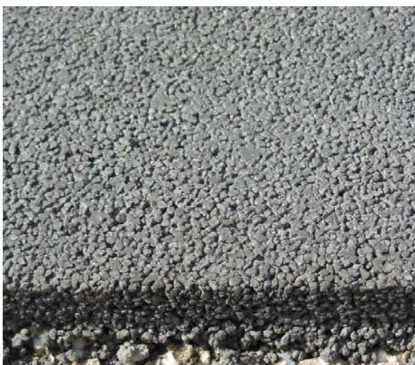
圖 14 高透水耐磨鋪面
