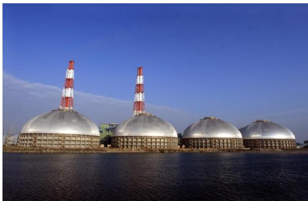
圖 4 台電公司興達發電廠室內煤場實績照片
