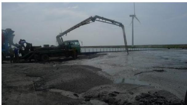
圖 30 防止水面下澆置造成材料析離之特密管施工過程
