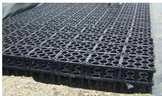
圖 9 雨水儲留滲透水箱(網路照片)
