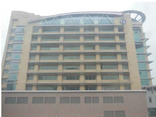
圖 15 楠旗 D/S 採用低輻射(LOW-E)玻璃搭配外遮陽設計
