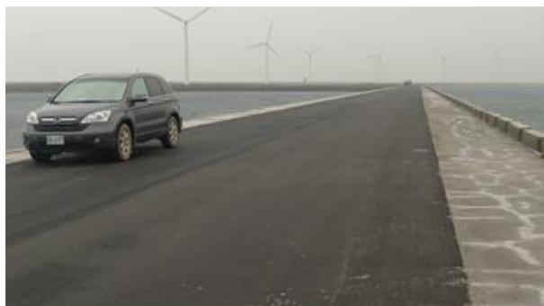
圖 31 完成之煤灰 CLSM 隔堤道路
