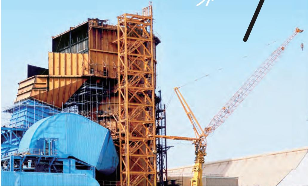
排煙脫硫吸收塔是硫氧化物排放防制設備，將燃煤發電產生的煙氣引接至塔內，以吸收作用去除硫氧化物，目前正進行設備更新升級，將脫硫效率提升至**96.5%**。
