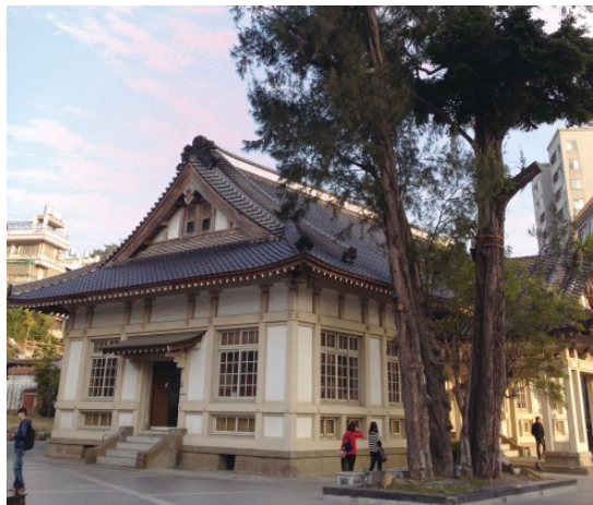
日治武館的武德殿為縣定古蹟。
