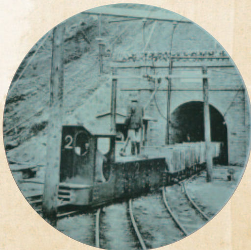
1930年時礦坑車輛動力源原為蒸汽機，經台電推廣用電後，部份礦坑車輛動力源開始改為電氣化。
