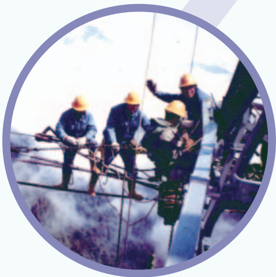
高山、雲海皆於足下，環境雖險峻，但工作熱情不減。(作者和北施處線路三段及南施處兄弟們於海拔三千公尺進行新東西線 345kV 鐵塔緊線工作，1998。)
